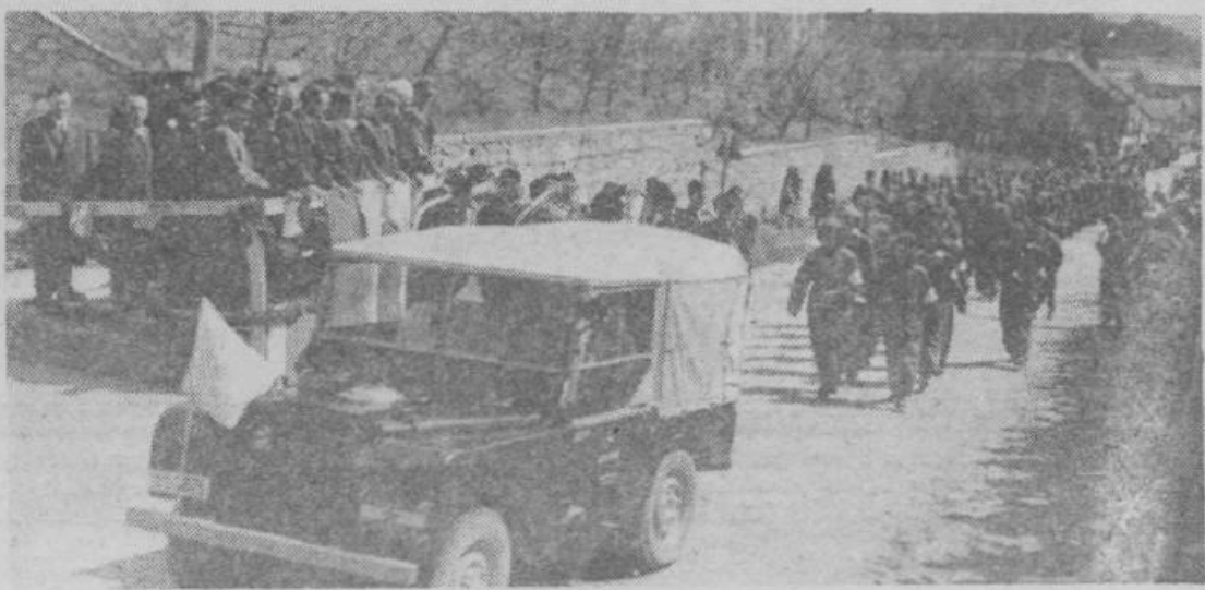
Mimohod enote protiavijske zaštite po sednji Adamičevi cesti
