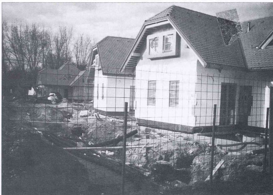
PREKMURSKA VAS – dela pri gradnji apartmajskega naselja v zdraviliškem kompleksu v Moravskih Toplicah se približujejo zaključni fazi
