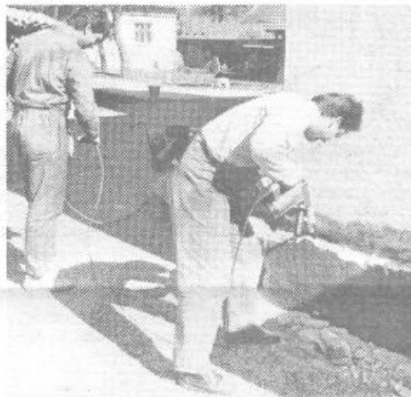
Gasilca pri pripravi zidu za izolacijo
