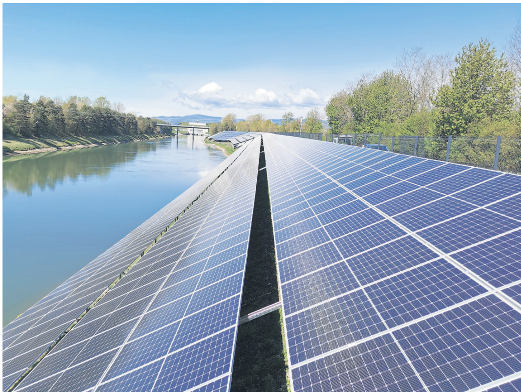
Družba HTZ je za peti segment Sončne elektrarne Zlatoličje namestila 5.694 visoko učinkovitih fotonapetostnih modulov s kupno nazivno močjo 2,5 megavata.
