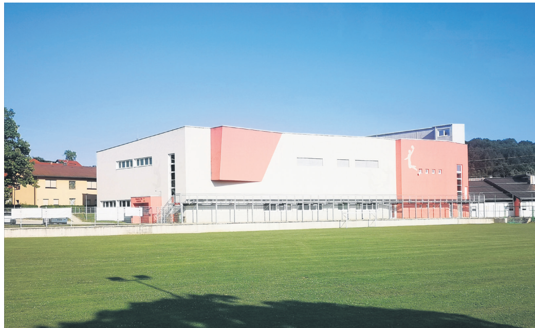
Sončna elektrarna, ki jo bodo postavili na strehi športne dvorane v Vojniku, bo proizvedla približno sto tisoč kilovatih ur električne energije na leto in bo s tem pokrila potrebe dvorane po električni energiji. (Foto: BA)
