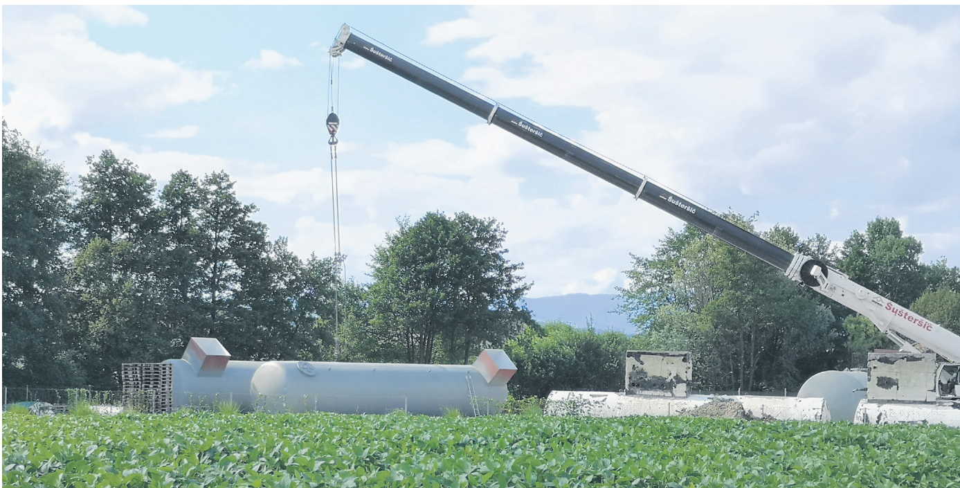
Veliki cisterne na zemljišču trgovine Hojnik pred vkopom v zemljo (Foto: TC)
