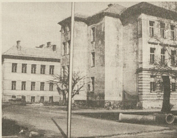
Stare šolske stavbe v Ribnici nudijo žalosten pogled — dokaz naše skupne nemoči pri zagotavljanju denarja za vzdrževanje podobnih objektov
