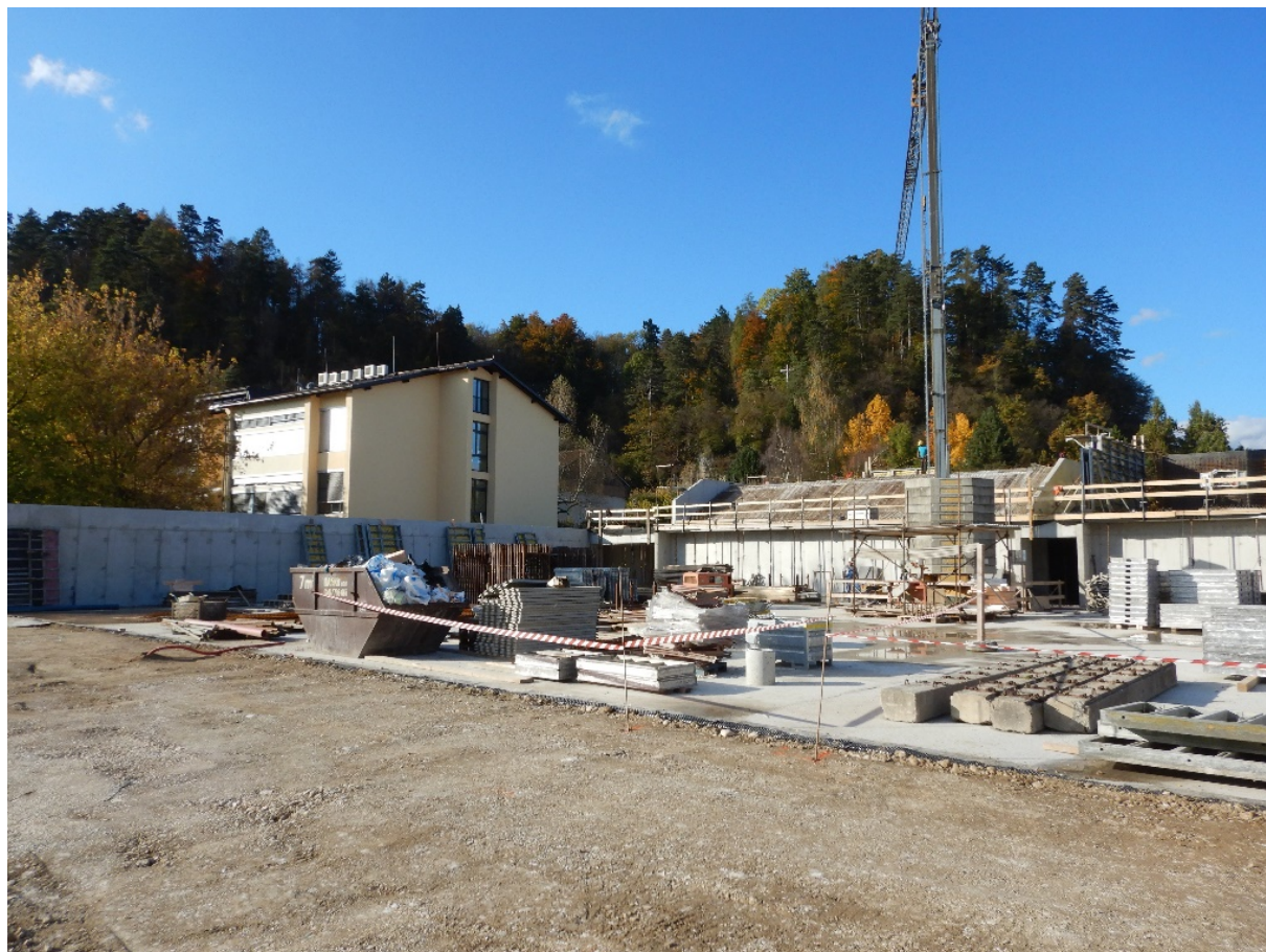
Slika 3. Betoniranje osnovne konstrukcije (osebni arhiv).
