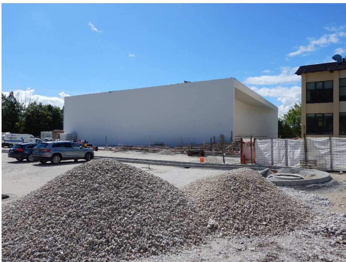
Slika 9. Gradnja parkirišča (osebni arhiv).
