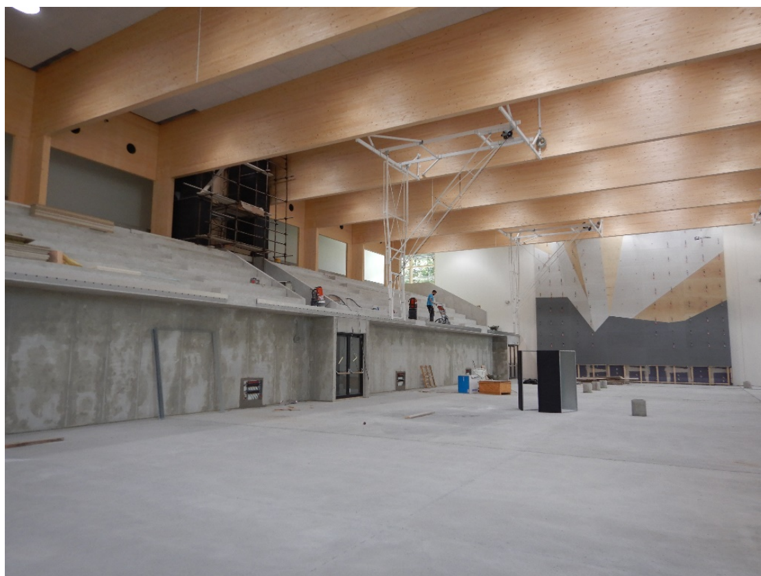
Slika 7. Gradnja notranjosti (osebni arhiv).
