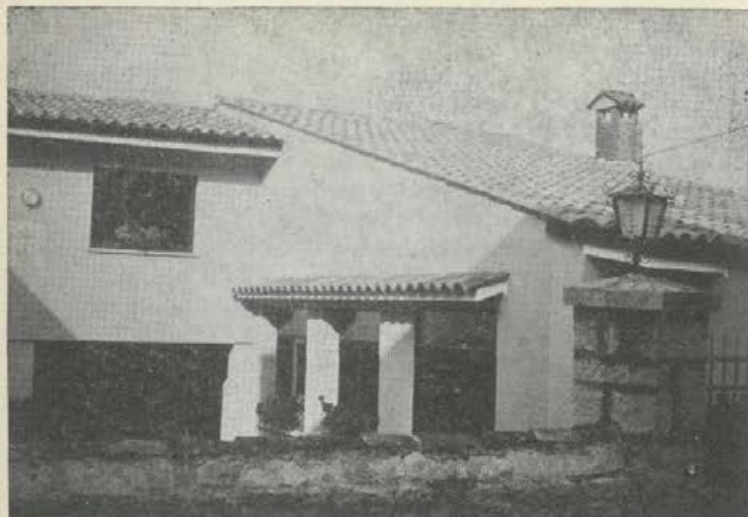
Pročelje nove župnijske dvorane v Nabrežini
