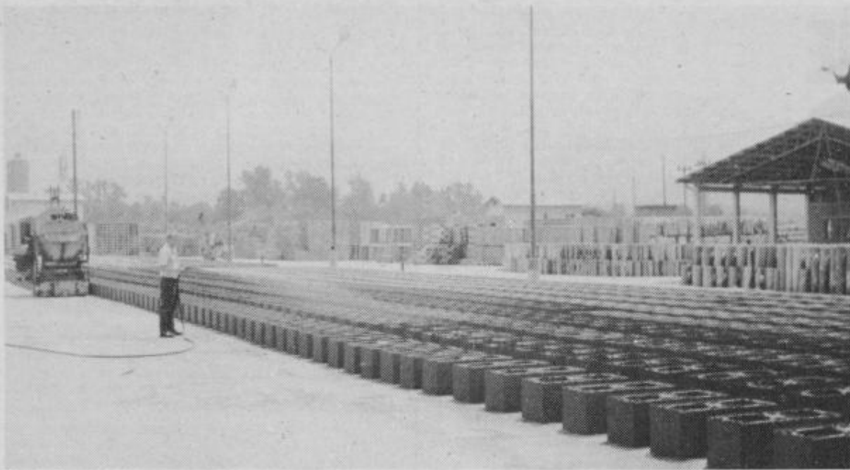
Pogled na del obrata Gradnje v Latkovi vasi
