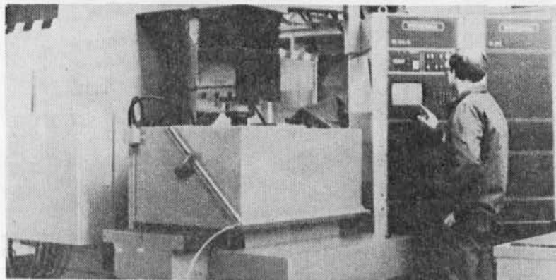
Odpraševanje na stroju za poliranje torzijskih gredi kljub kupljeni napravi več mesecev ni delovalo
