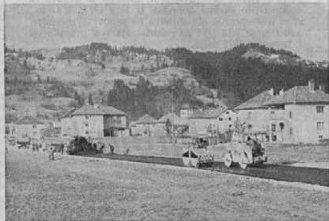
Z asfaltiranjem bomo nadaljevali
