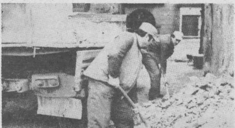
Prenovitev stanovanjske hiše Stari trg 6. Težave pri delu predstavlja tudi deponija. Naši delavci odvažajo star izkopan material s kamionom.
