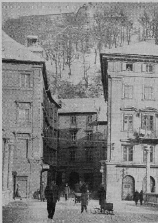
Sl. 4. Pogled s Čevljarskega (Gornjega) mostu proti stavbišču nekdanjega Komuna oz. Tranče
