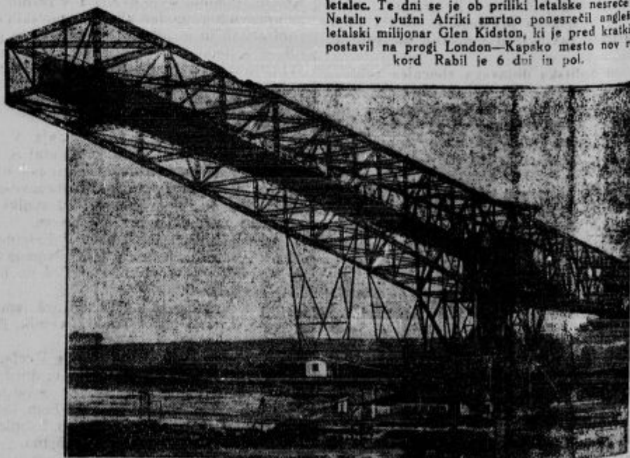
Največji prečni most na svetu. V rudniku Golpa, ki je last podjetja »Elektro-Werke A.-G.«, so te dni prvič stavili v pogon 400 metrov dolg prečni most, ki je največji te vrste na svetu. Služil bo za odstranjevanje peska, ki leži nad rjavim premogom.
