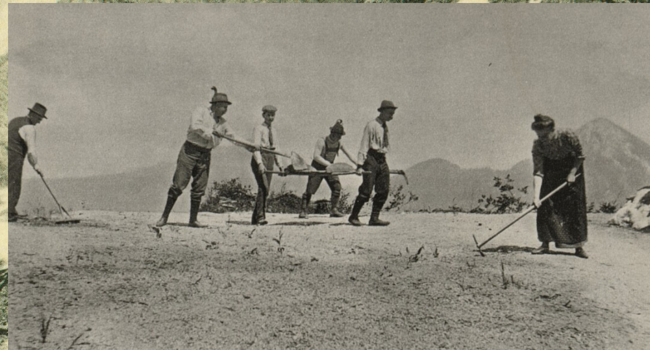
Priprava temeljev za Češko koč
