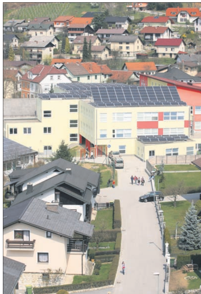
Sončna elektrarna je nameščena tudi na strehi OŠ Vojnik. V neposredni bližini zdaj gradijo nizkoenergetski Vrtec Mavrica, prihodnje leto pa sledi še gradnja prve pasivne telovadnice v Sloveniji.
