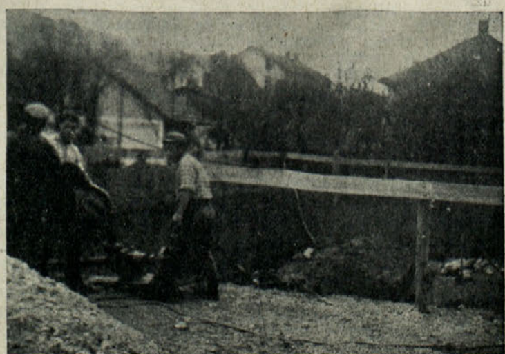
Med betoniranjem temeljev za novi 20-stanovanjski blok, ki ga gradi SGP Zidar za svoje delavce v Šeškovi ulici v Kočevju
