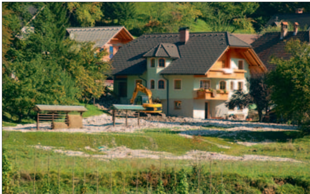
Slika 3: Poplava 18. septembra 2007 je ogrozila novogradnje v kraju Nomenj.
