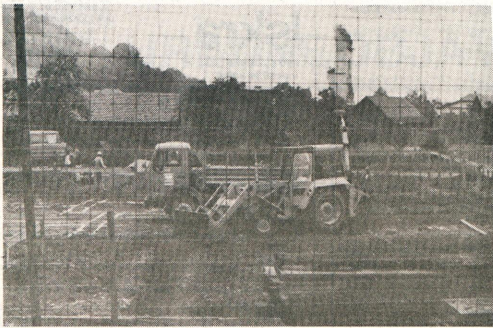
Na gradbišču novega vrtca v Borovnici so stekla zemeljska dela. Gradbeni odbor predvideva, da bo pred zimo vrtce že pod streho.
