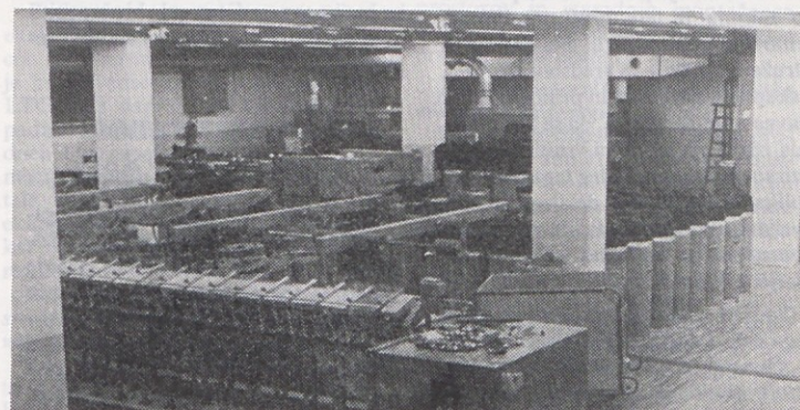
Oddelek v naši predilnici, v katerem en delavec posluhuje vse faze dela predpredilnice. To se dela ob rahljalniku bal, mikalniku, raztezalki in flyerju.
