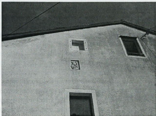
Relief sv. Petra na fasadi hiše v Beblerjevi ulici
