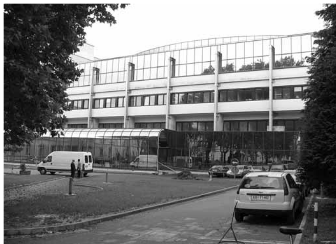
Prenovljena stavba D z glavnim vhodom.
