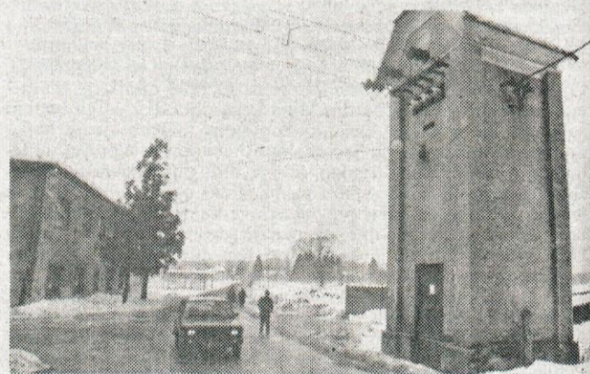
Stolpasta transformatorska postaja v Križah se zaradi razširitve regionalne ceste "umika" nasproti objekta Zlit.
