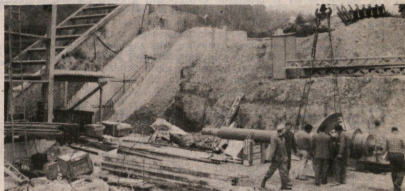
Včeraj so pričeli vgrajevati os vodne turbine HE Monte Fortin pri Farri na Goriškem
