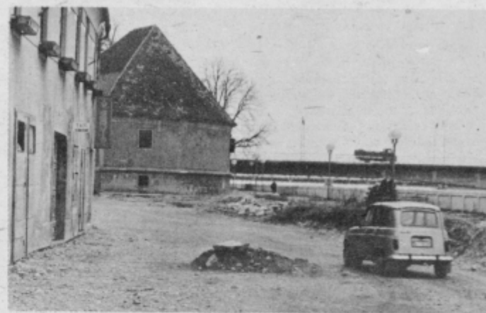
Obnova Dravske ulice v Ptujju, dokončanje vseh del je prekinila zima Foto: M. Ozmec
