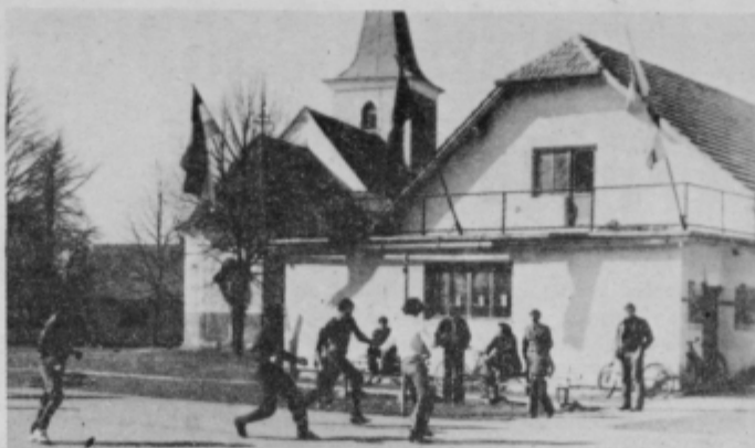
Dom prosvetnega društva v Kungoti kliče po obnovi.
