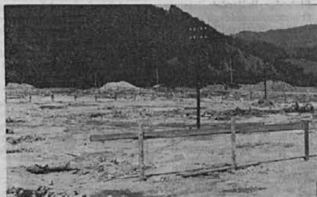
Zakoličena proizvodno-skladiščna hala je že začela dobivati podobo
