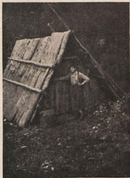
„Holcarska“ bajta. fot. Dovjak.
