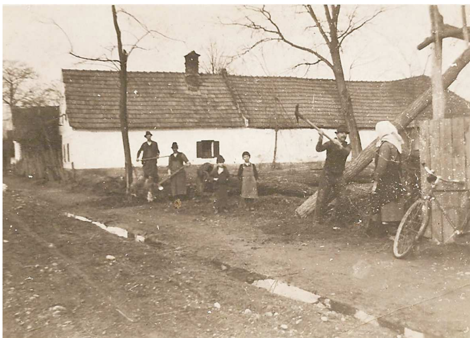
Kopanje droga za elektrifikacijo, v ozadju Božičkova (Pepelnikova) hiša, 1946, Vir: Antonija Kukolj, rojena Fuks, Maribor
