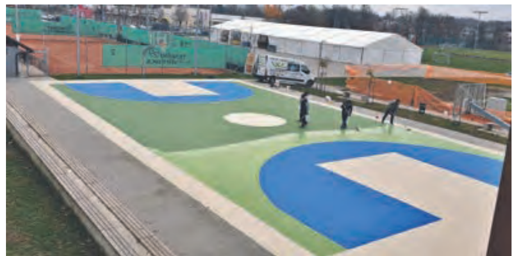
Preplastitev košarkarskega igrišča z novo protizdrsko podlago
