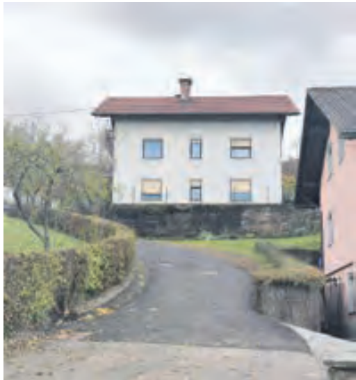
Asfaltirana klančina na Dolu
