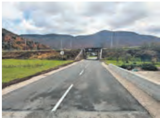
Obnova ceste na Dražici pod kolonco
