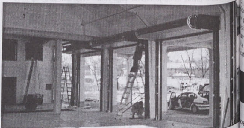
Montaža premičnih vrat na zahodni strani novega gasilskega doma.
