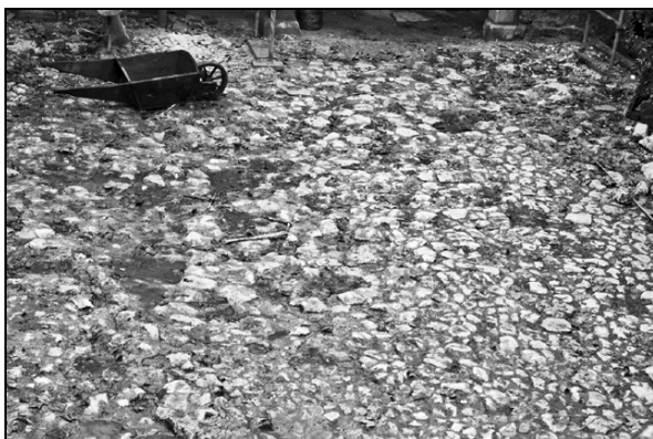
Izvirni kamniti tlak na dvorišču (fototeka ZVKDS, OE Kranj).
