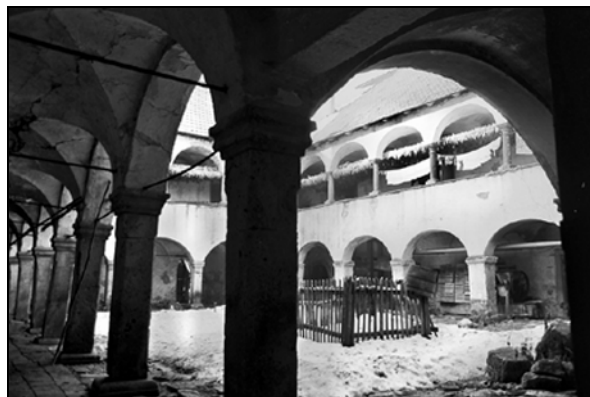
Arkadno dvorišče leta 1971 (fototeka ZVKDS, OE Kranj).
