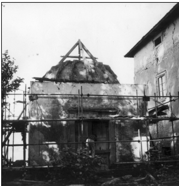
Grajska kapela z vidno leseno konstrukcijo kupole med obnovo leta 1991 (fototeka ZVKDS, OE Kranj).
