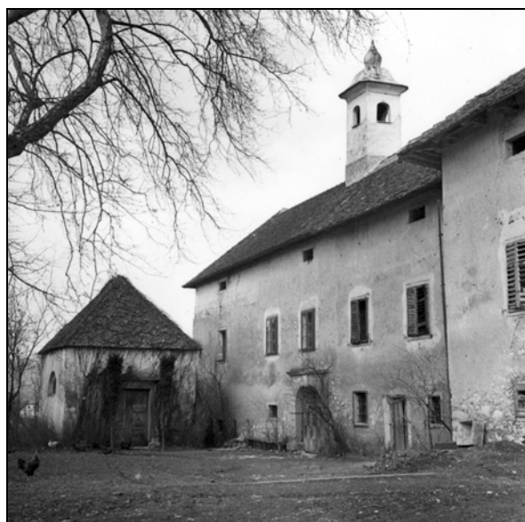
Vhodno pročelje s kapelo leta 1966 (fototeka ZVKDS, OE Kranj).
