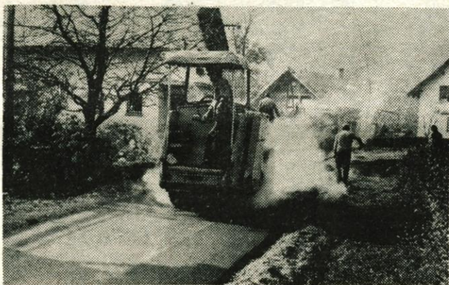
BLAD — Krajevna skupnost Bled je začela z akcijo asfaltiranja vseh tistih makadamskih cest, ki so do letos čakale zanemarjene in ozke. Asfaltirali bodo prav vse vaške poti in tako na skupaj 22.000 kvadratnih metrov položili asfalt. Denar za obnovo je prispevala krajevna skupnost, najeli so kredite Ljubljanske banke, pomagajo pa z lastno udeležbo tudi občani. — Foto: J. Zaplotnik
