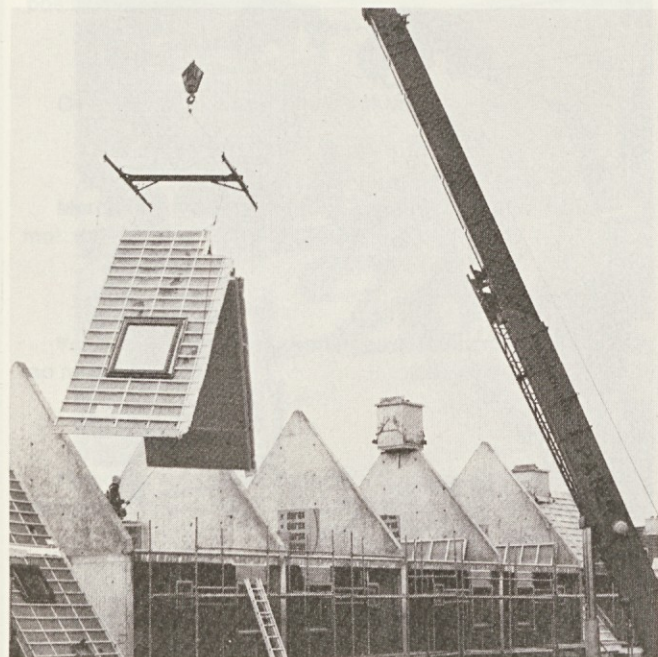
Montaža strešnih segmentov v funkciji nosilne konstrukcije za kritino ter hidro in toplotne izolacije.
