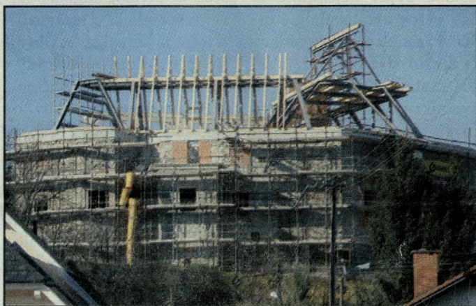
Intenzivna dela pri obnovi gradu Komenda
