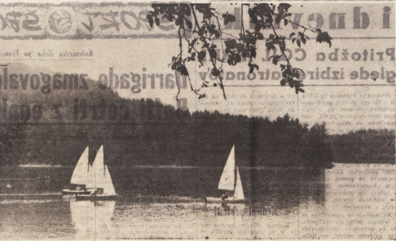
Nedaleč od Ljubljane proti Kranju so zajezili Savo, da bi njene vode poganjale novo centralo v Medvodah. Tu se je ustvarilo novo Zbiljsko jezero, na katerem so pred kratkim imeli tudi regato. (Foto Selhaus)
