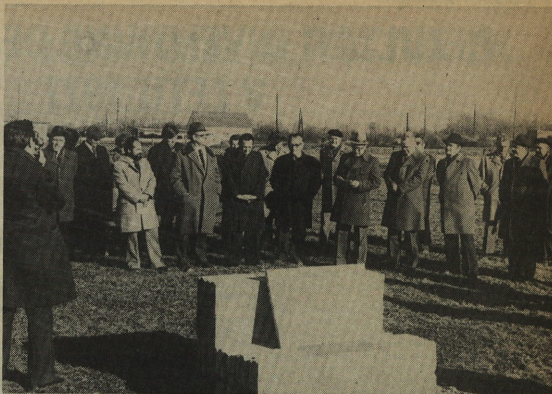
Z otvoritvene slovesnosti ob začetku gradnje Emone v Ljutomeru
