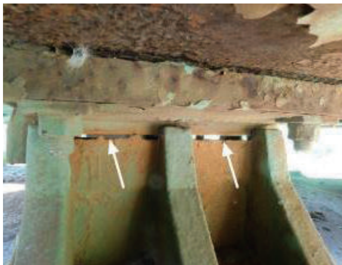
Slika 5 • Zračnost ležišč (9 mm in 8 mm).
