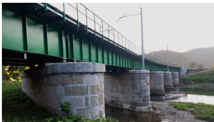
Slika 22 • Most po sanaciji.
