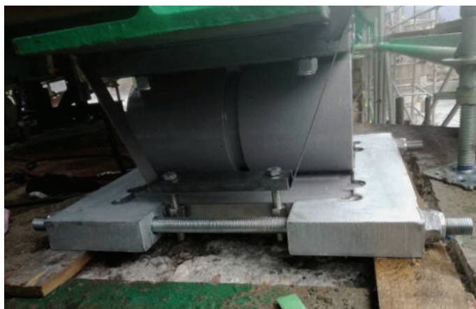
Slika 15 • Montaža objemnih jarmov in opaz za podlivanje ležišč.
