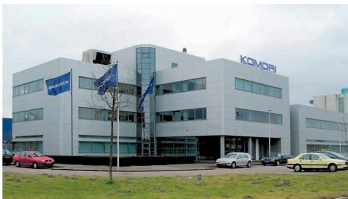
Slika 12. Komorijeva evropska centrala v Utrechtu na Nizozemskem.
