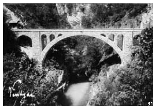
Sl. 31: Kamniti lok mostu čez Radovno v Blejskem Vintgarju meri 40 metrov. Na bohinjki progi je edini tak most, ki je ohranjen v prvotni obliki iz leta 1906. Ob pogledu nanj se ni mogoče upreti primerjavi s srno ali gazelo v skoku. Razglednica: zbirka Železniškega muzeja SŽ.
