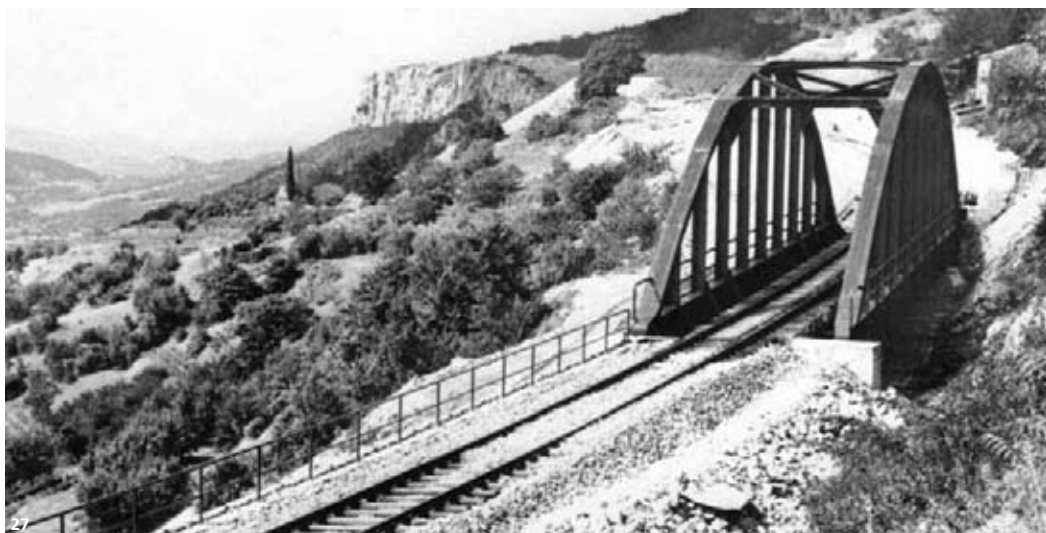
Sl. 27: Most iz Gozda Martuljka v novem življenju premošča zemeljski plaz pri vasi Podpeč. Foto: Pleterski.
