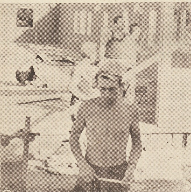
Skupina tesarjev pri montiranju sestavnih elementov barak. Pri tem delu so se zelo izkazali Skopjeločani
