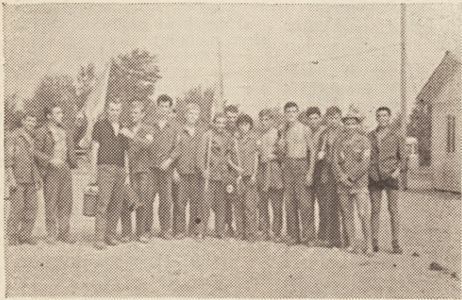
Pri izkopavanju temeljev so nam v pomoč tudi brigadirji, ki delajo v dopoldanski in popoldanski izmeni
