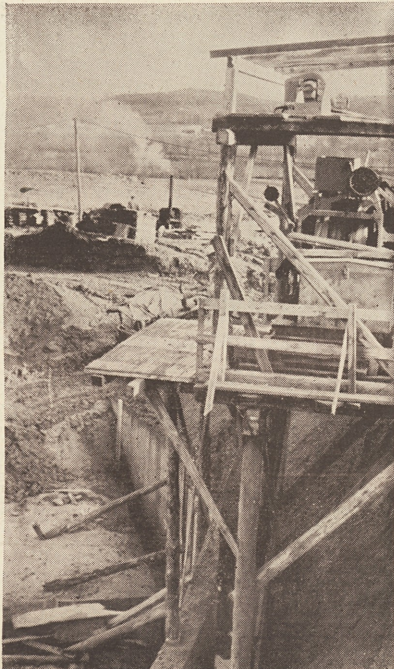
Tako rekoč sredi njive bo stala nova vinska klet v Ormožu. Zaščetni obok kleti je že zabetoniran
