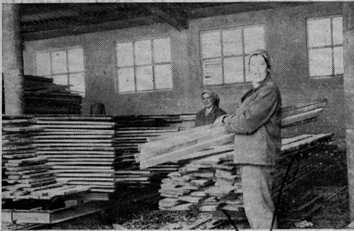
Priprava lesa za izdelavo gradbenih plošč
