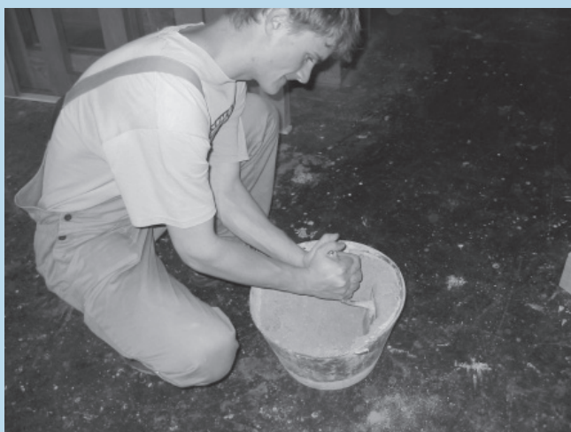
□ Slika 3. Za mizarsko delavnico zelo nenavaden pogled: mešanje betonske mase
