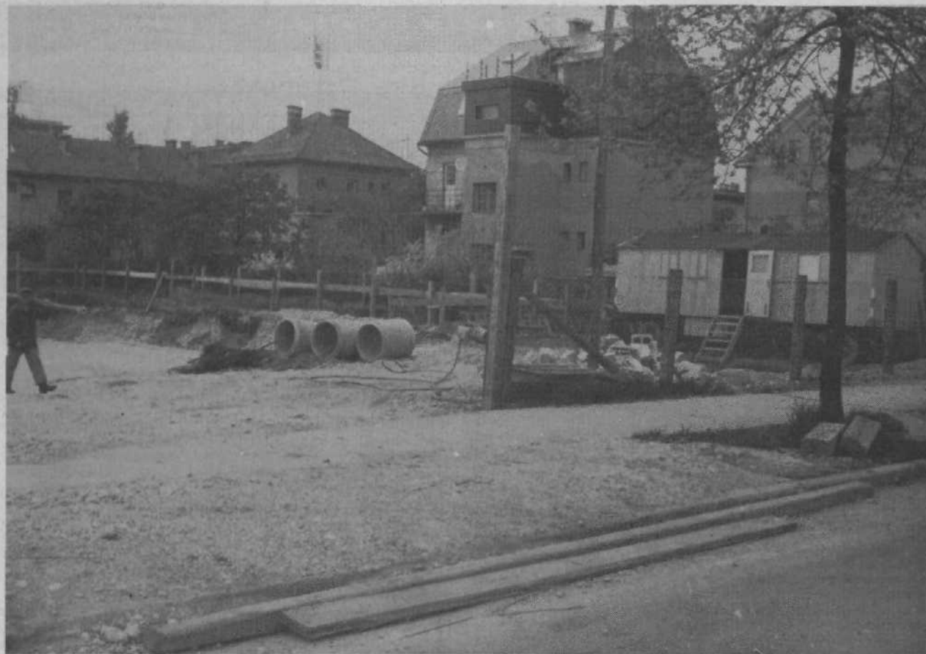
Dolgoletne želje bežigraskih mladičev se bodo kmalu uresničile. Iz starih, popolnoma neustreznih prostorov, se bodo konec letošnjega ali v začetku prihodnjega leta preselili v novo stavbo, ki so jo začeli graditi v Posavskega ulici. V pritličju, treh nadstropjih in kleti bo 1909 metrov uporabne površine, kjer bodo prostori postaje mlilce, garaže in stanovanja za uslužbenke. Gradnja bo stala skoraj 27 milijonov dinarjev, denar pa bodo zagotovili občinska skupščina, republiški sekretariat za notranje zadeve in uprava javne varnosti.
