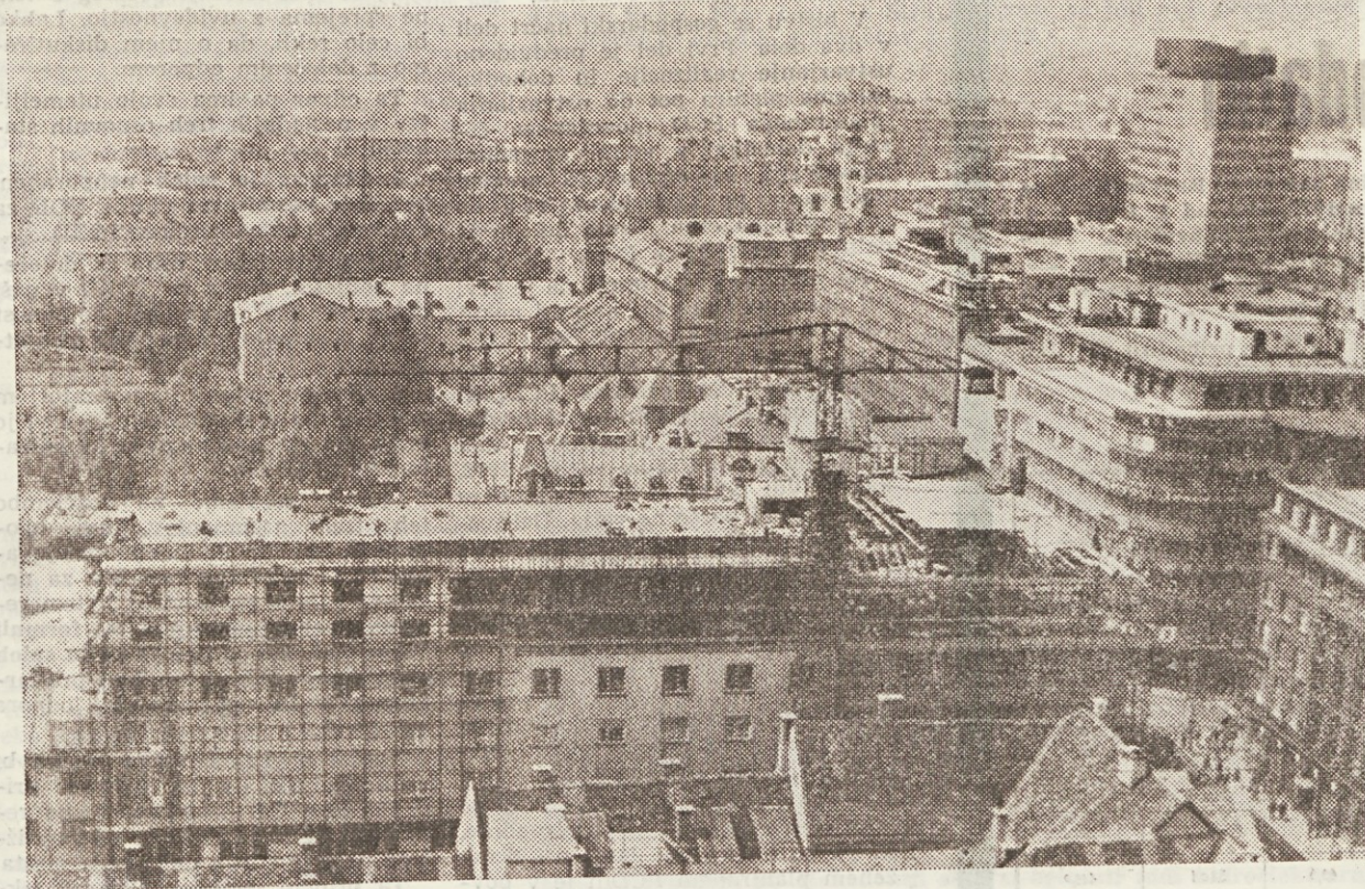
Nadgradnja hotela Slon v Ljubljani — Posnetek je z Metalke
