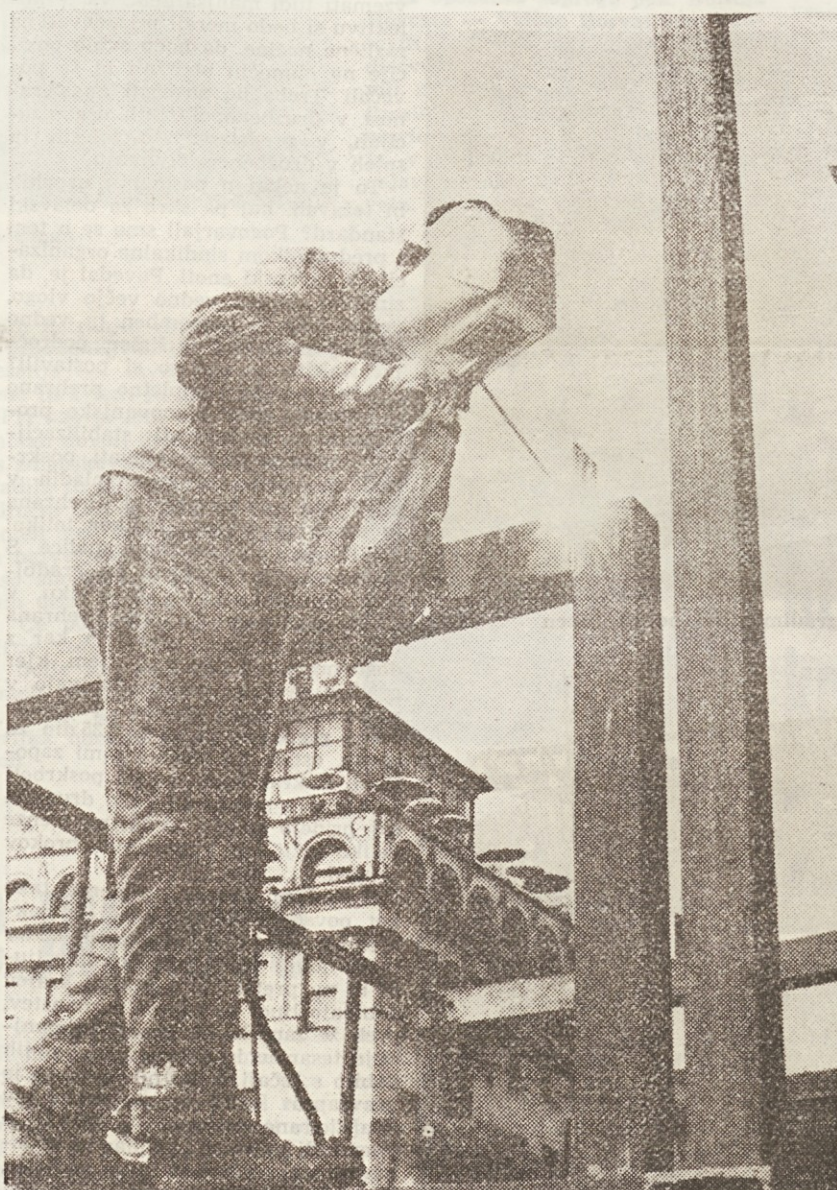
Nadgradnja hotela Slon — detalj z gradbišča — varilec
