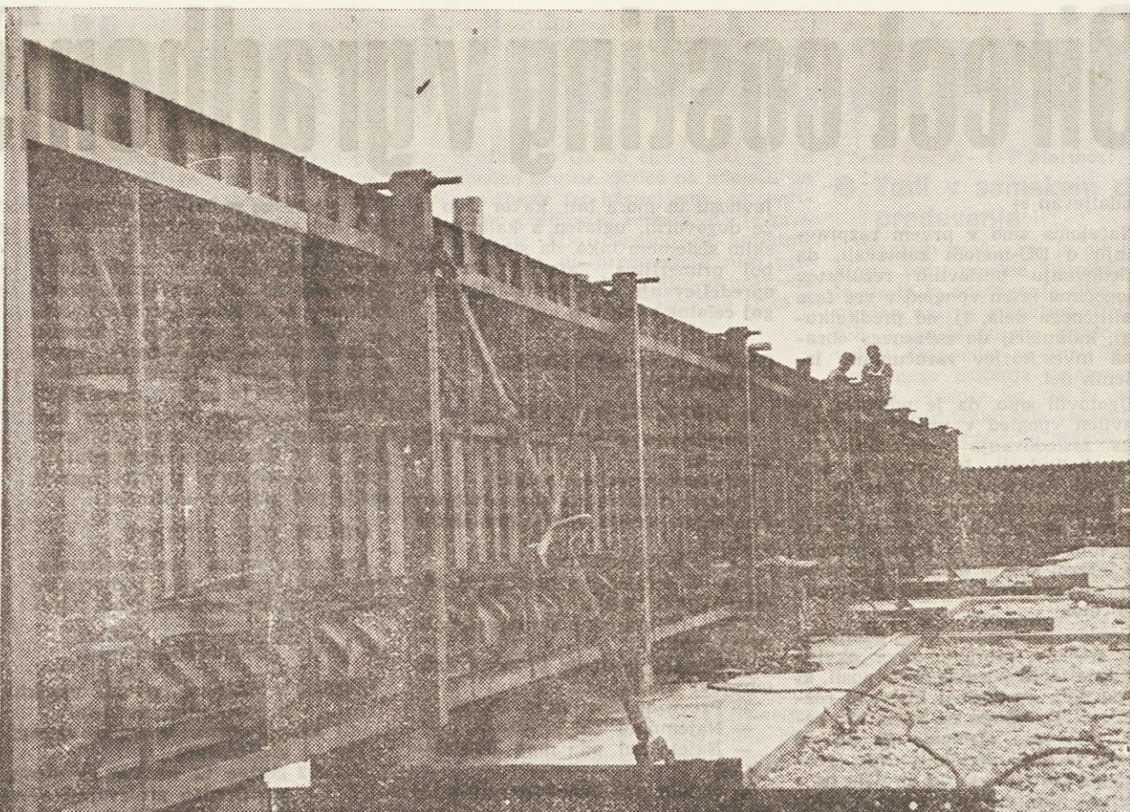
Predelava opaža za nosilec viadukta
