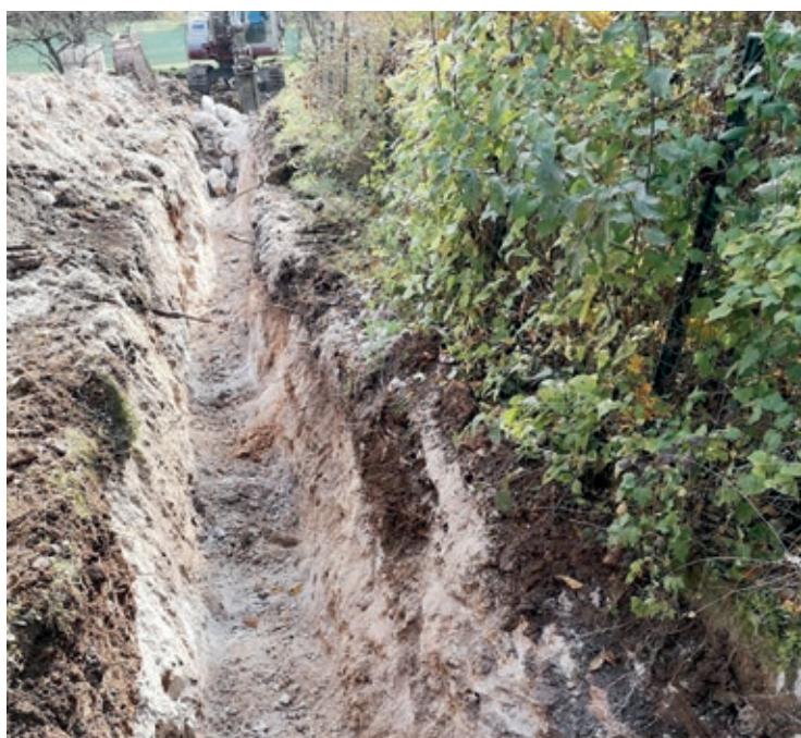
Obnova vodovoda na Malem vrhku
