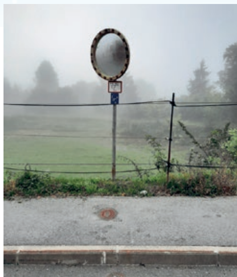
Podtalni hidrant na pločniku z označbo o lokaciji
