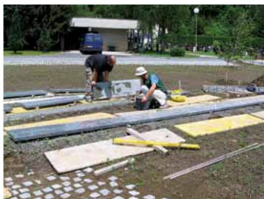
Zaključna dela pri montaži grobnih plošč na pokopališču v Lipici. (foto: Marko Vraničar)
