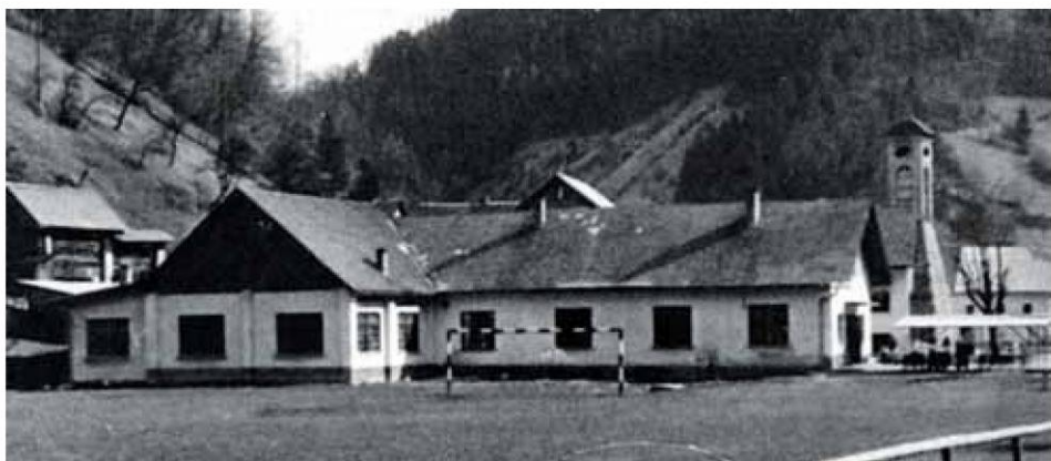
Poslovni prostori Tehnice na začetku 60. let prejšnjega stoletja. (iz zbornika: Tehnica 1959–2009 )
