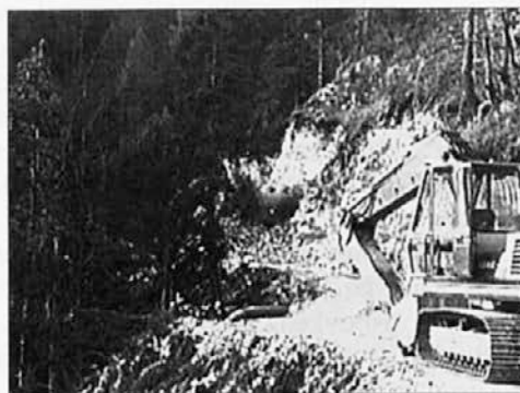
Gradnja gorske ceste.
