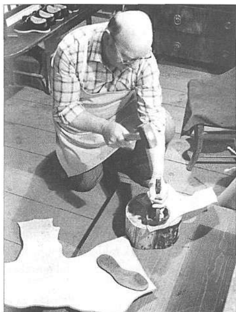
Ročno izsekavanje petnih delov (foto Alenka Krašovec, fototeka Tržiškega muzeja, inv. št. 1530). ♦ Manual cutting of heel parts (photo Alenka Krašovec, picture library of the Tržič Museum, inv. no. 1530)
