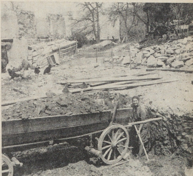
Če danes pogledamo prizorišče požara, prav gotovo ni več tako strašno kot takrat. Ruševine so že očiščene in sosedje pomagajo, kolikor morejo in še vedno enako nesebično kot neposredno po nesreči. O hudem požaru pa priča golo drevje, ki ne bo nikoli več ozelenelo.
