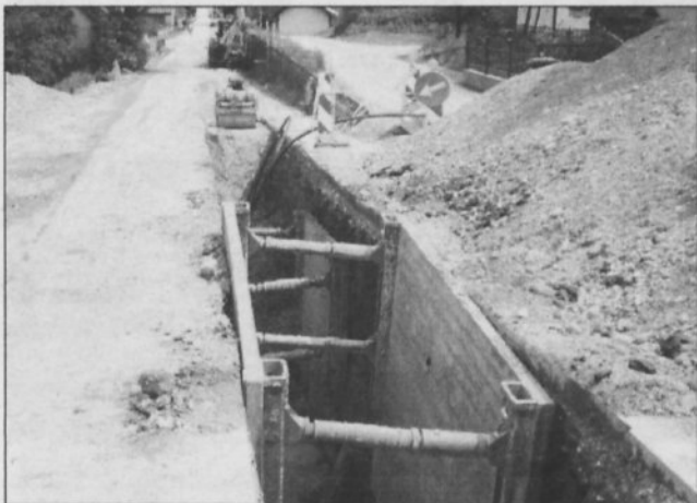
Gradnja kanalizacije na Drnovem
