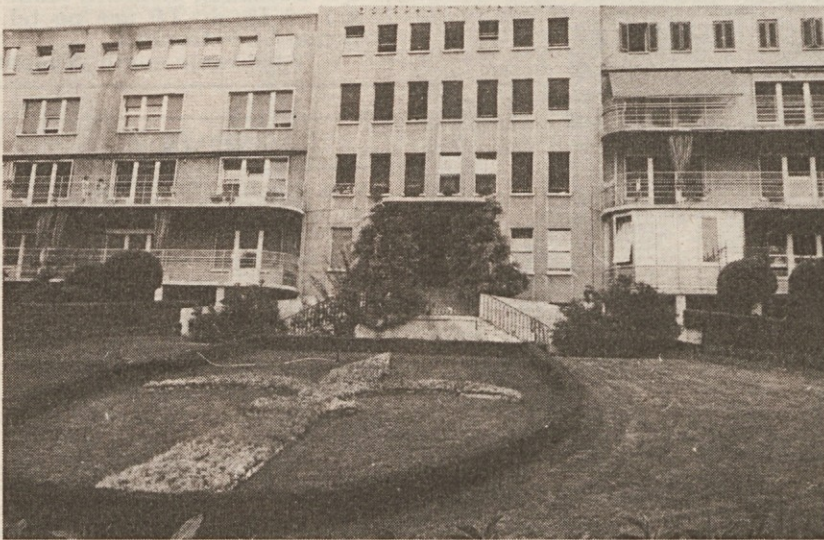
Pogled na notranji park otroške bolnišnice
